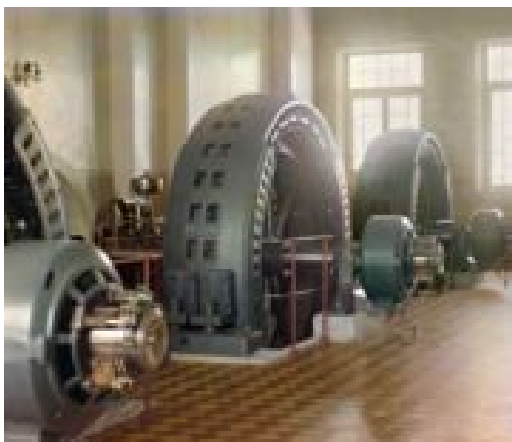
Fig. 2- Hidroelétrica de Itaipu.
